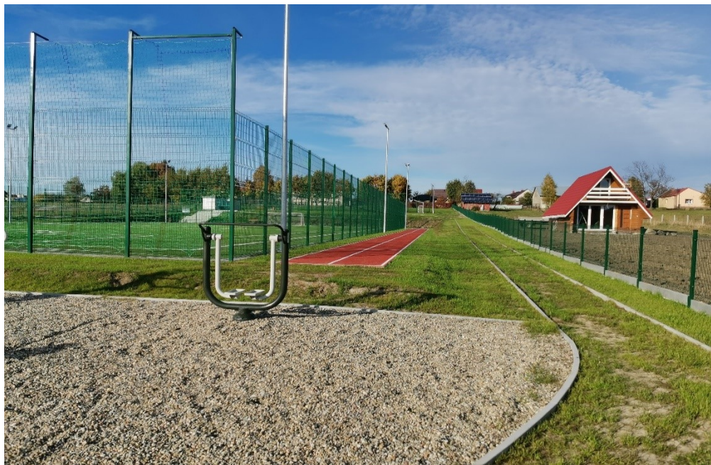
Fot. Wykonany kompleks sportowy w Lipnicy
