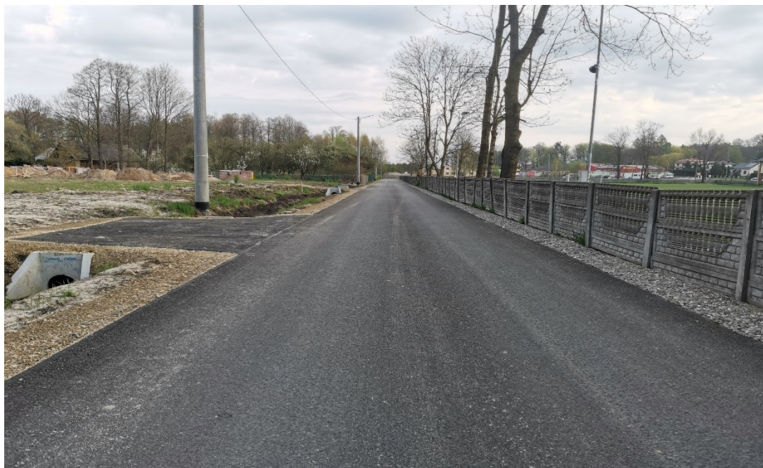
Fot. Wykonana przebudowa drogi nr 104306 R i 104305 R ul. Sportowa
