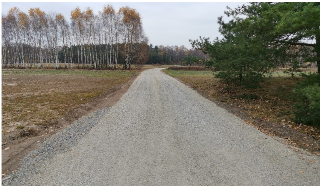
Fot. Wykonana droga dojazdowa do pól w miejscowości Wilcza Wola.
