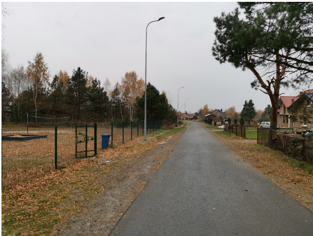
Fot. Wykonane oświetlenie uliczne w miejscowości Wilcza Wola
