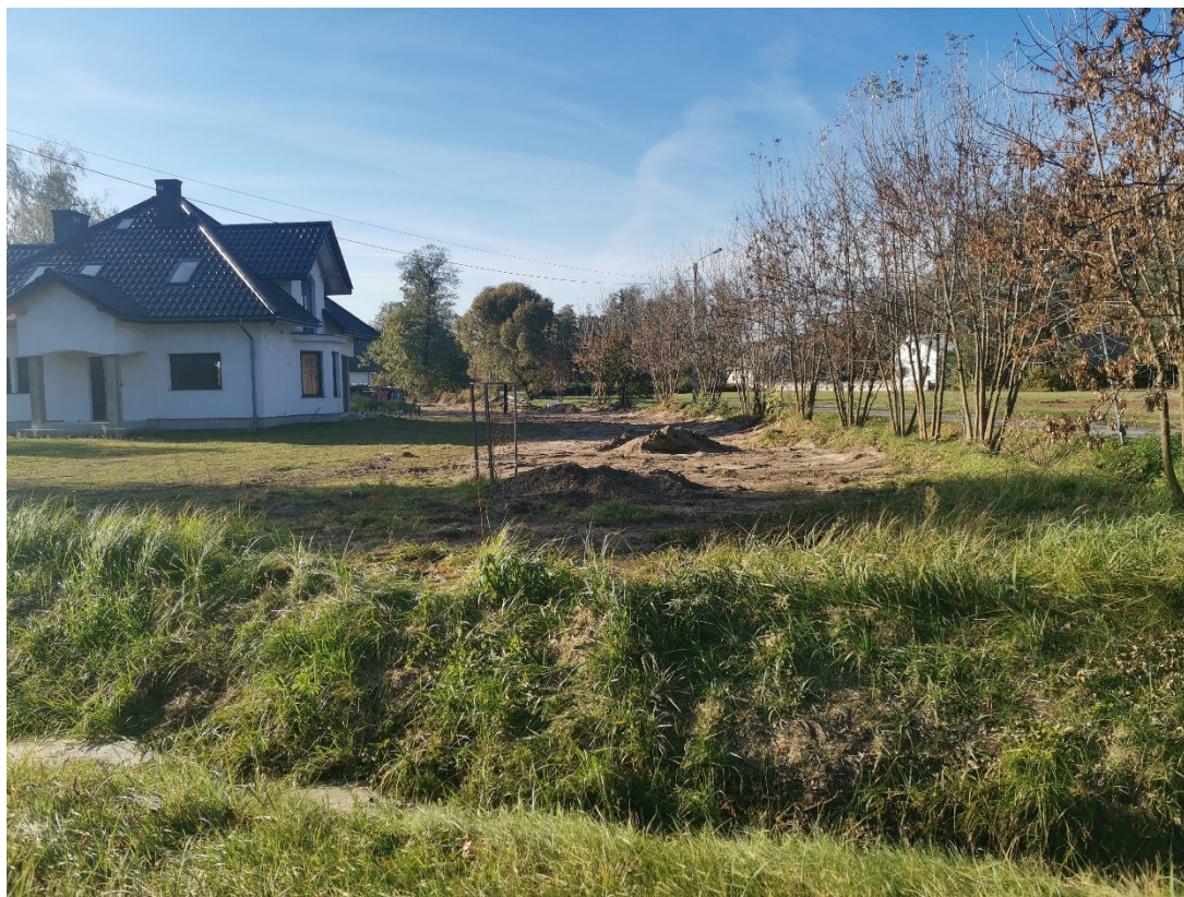
Fot. Budowa kanalizacji sanitarnej w miejscowości Kopcie w trakcie realizacji.
