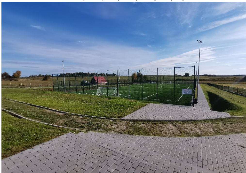
Fot. Wykonany kompleks sportowy w Lipnicy
