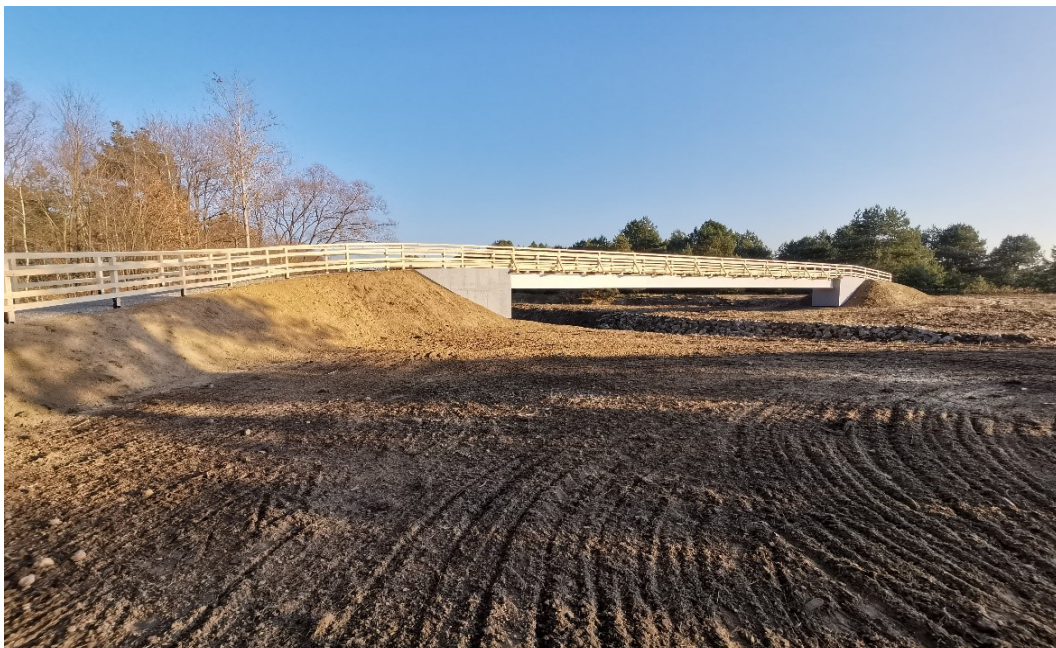
Fot. Wykonana kładka dla pieszych w miejscowości Kopcie (przysiółek Zapole)
