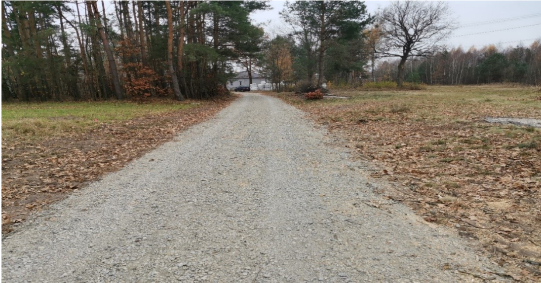
Fot. Wykonana droga dojazdowa do pól w miejscowości Kopcie
