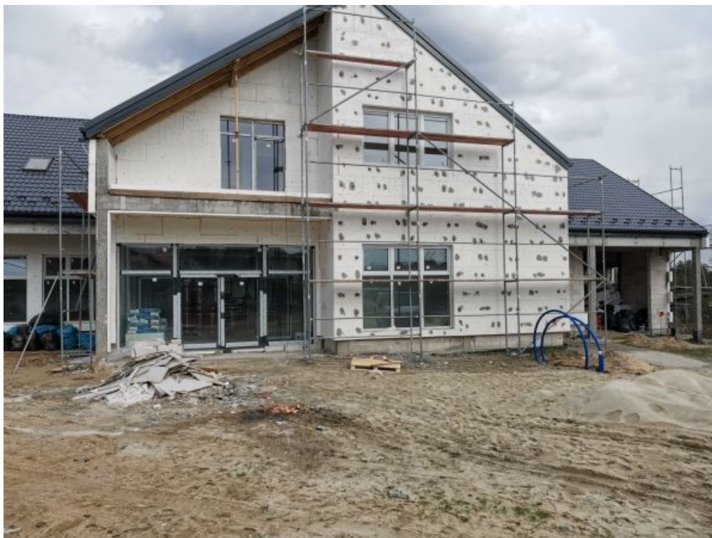
Fot. Rozbudowa i przebudowa budynku wielofunkcyjnego w Kopciach.
