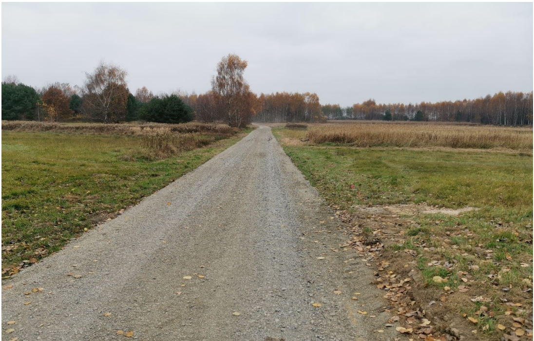
Fot. Wykonana droga dojazdowa do pól w miejscowości Lipnica.
